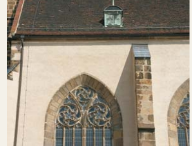
Abb. 3 Bautzen, Dom, Oberputzfarbgebung mit natürlichem Sand
