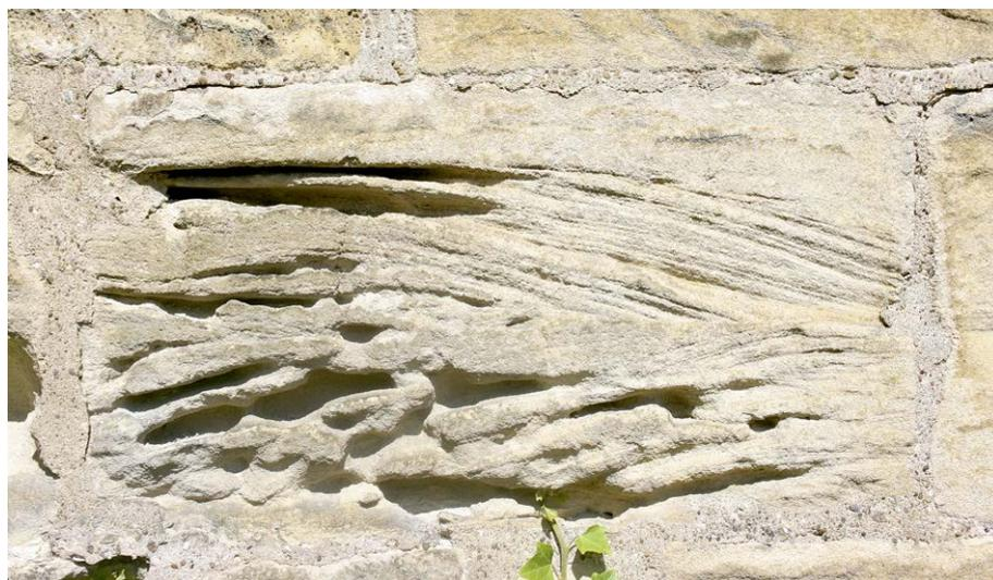
(6) Salzinduzierter Verwitterungsschaden, der die Sedimentationsschichten des Sandsteins nachzeichnet
